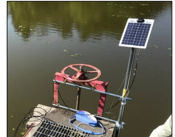
水位計測装置設置イメージ
