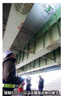
球殻ドローンによる橋梁点検の様子
